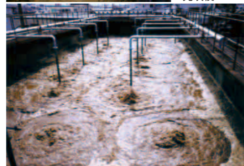
N-hex 500mg/ℓで上部に大量スカム BF充填により解消、鶏解体廃水(SBR式)
