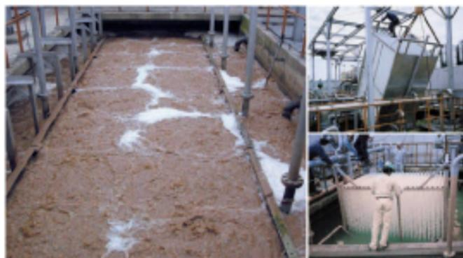
豆腐厂废水、充填BF后能力×3倍、减少污泥
